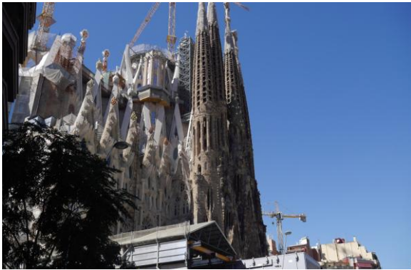
Remont Katedry Sagrada Failia
